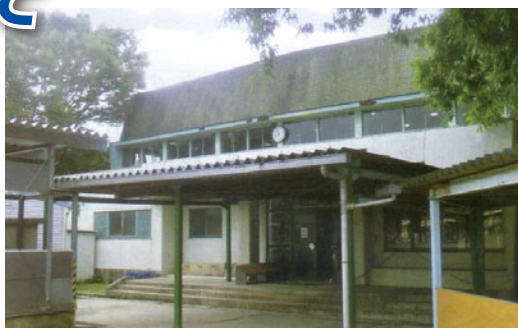
▲学校施設の老朽化対策は急務。
