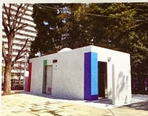
改修された北部球場トイレ
